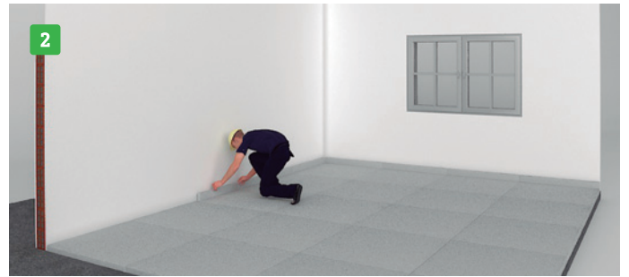
Colocar los zócalos cortados de Neosound ®, los cuales aseguran que el contrapiso quede completamente separado de la estructura y la mampostería.
