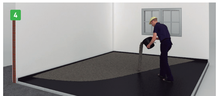
Colocar una malla de acero electrosoldada sobre el film con separadores. Volcar el contrapiso y realizar la carpeta.
